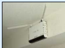
無料公衆無線LAN環境の整備
