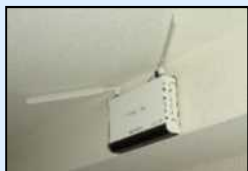
無料公衆無線LAN環境の整備
