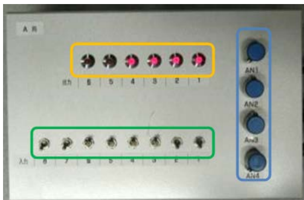
図7 デモ用融雪設備制御盤
