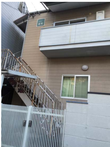
2階建て、地下に駐車場も完備
