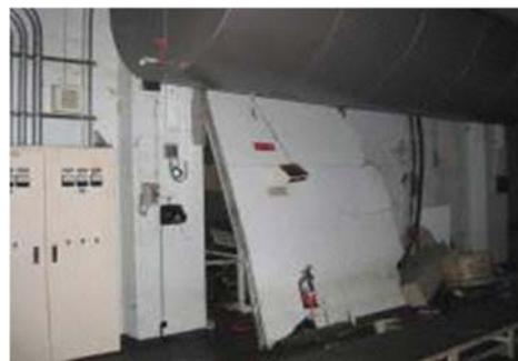
電力設備(1F)が大きく損傷
