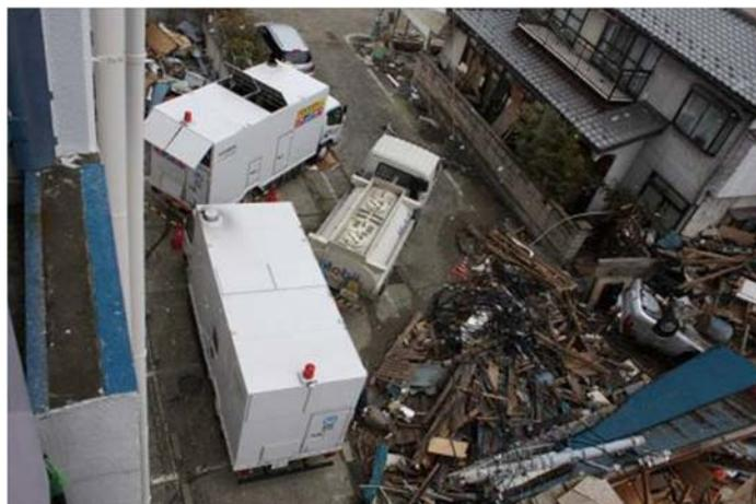
移動電源車・タンクローリーの配備により、通信サービスを復旧(3/19)
