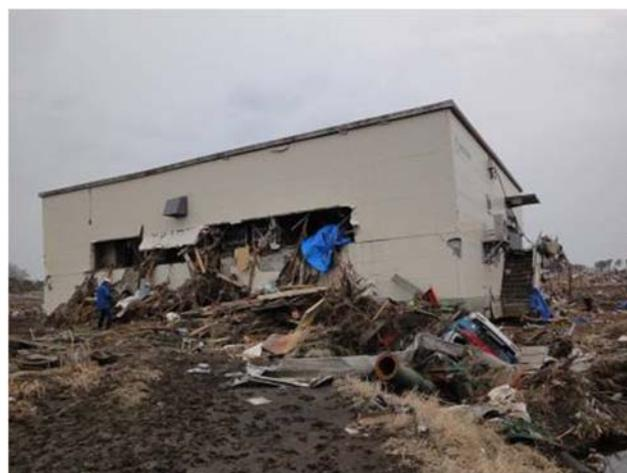
津波により流失し、基礎台ごと約500m流され全壊
