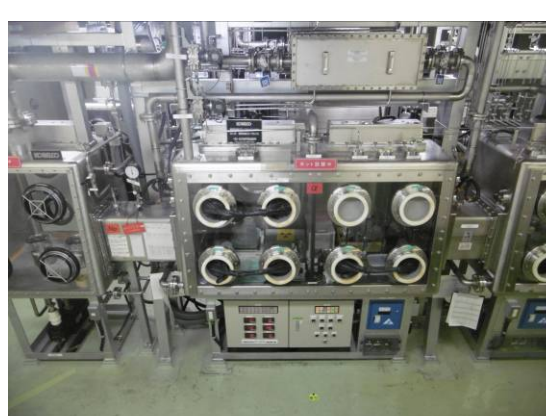
雰囲気制御装置グローブボックス設備
