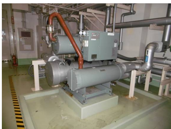
冷水・冷却水設備
