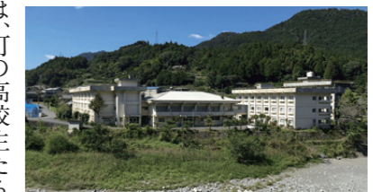
敷地の階段などに、かつての学生寮で使われていたものが資材として使われている。(写真は解体前の『青雲寮』)
