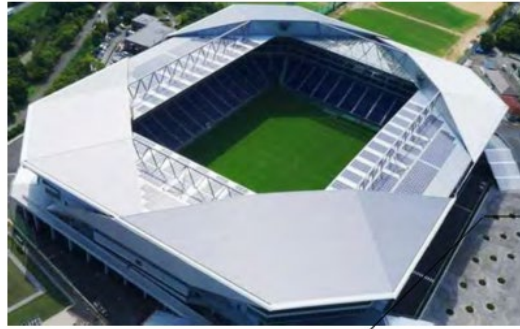
(a) スタジアムの外観
