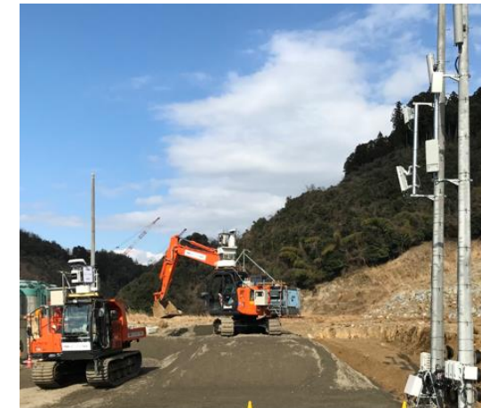
掘削・運搬・転圧など一連の道路造成工事を遠隔から施工
