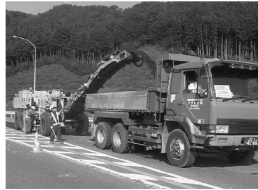
図 24 路面切削機（ダンプ後方の機械）
