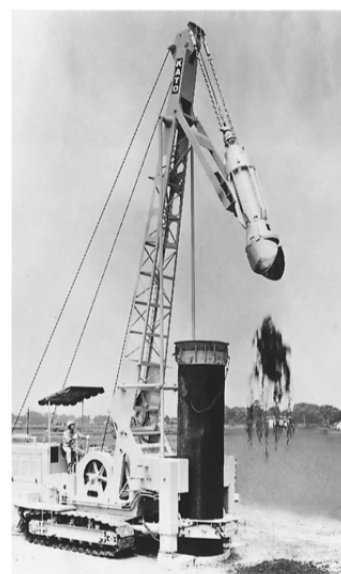
図 13 オールケーシング掘削機
