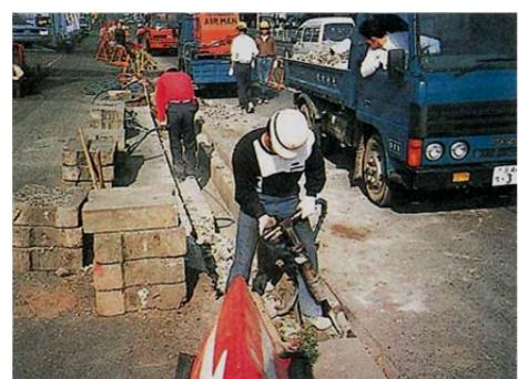
図 5-3 構造物の取り壊し作業
