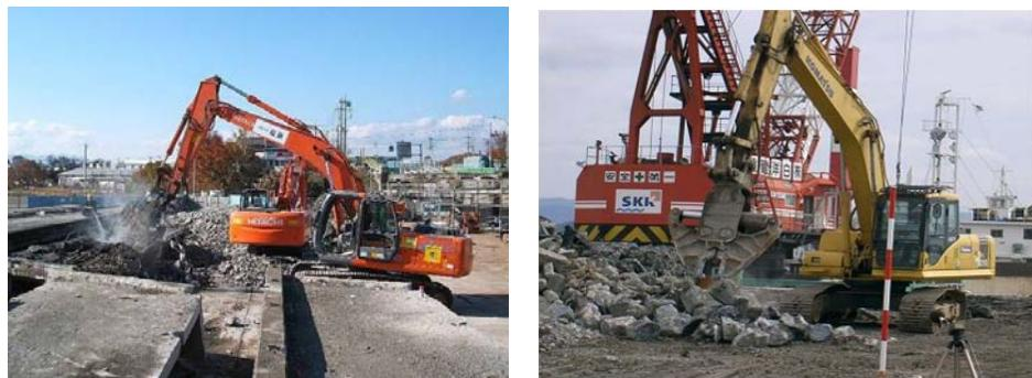
図 5-4 コンクリート圧碎機による杭破碎作業
