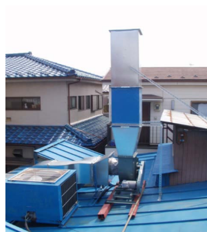
写真4 排出口の高さ、向きの改善の一例
