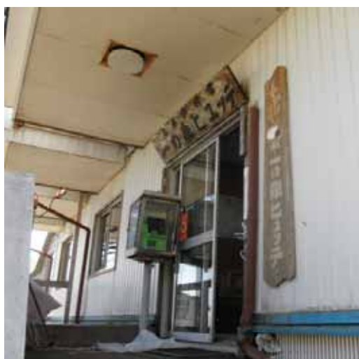
図 1-6 山小屋の公衆電話回線の提供例 (公衆電話)
