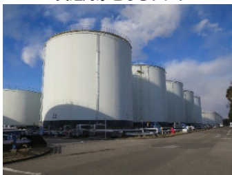
実証対象となるタンク
