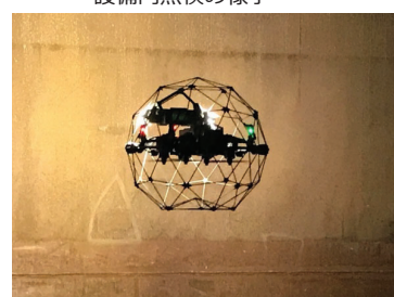
設備内点検の様子
