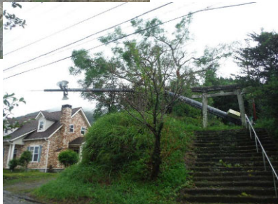
テレビ中継局や防災行政無線柱の倒壊被害
