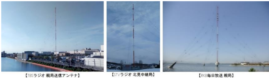
図表 29 AM ラジオ放送の送信設備
