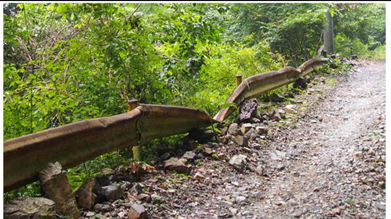
大雨や地震による落石が発生したが、斜面を補強する工事予算が確保できず、長期間通行止めを行っているもの
