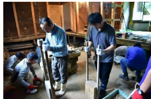
空き家改修ワークショップ
