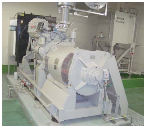
非常用発電設備
