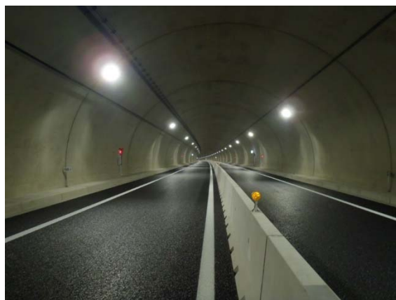
道路・トンネル照明設備
