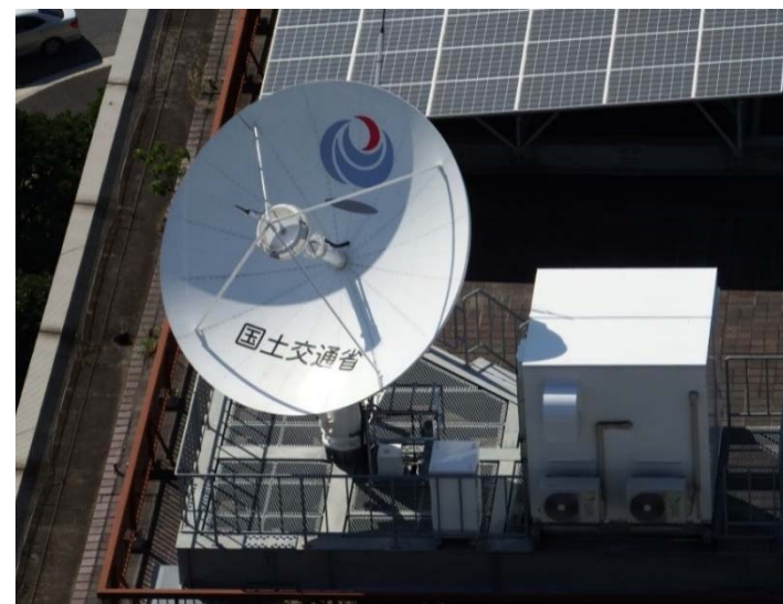
衛星通信設備
