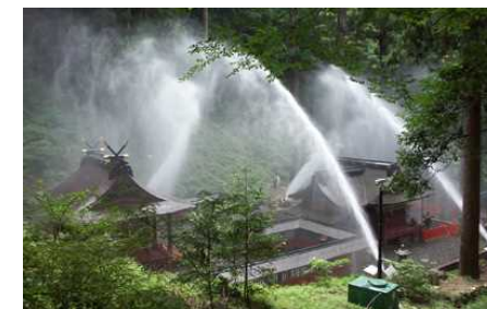
≪消火施設(放水銃)の設置≫
