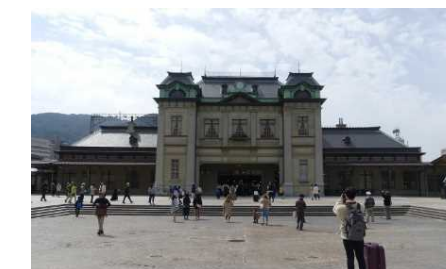
≪重要文化財(建造物) 門司港駅(旧門司駅)≫ 令和元年度に修理完了予定
