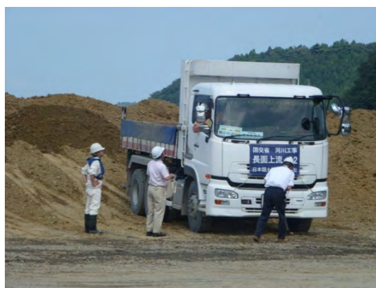
公共工事現場での無線局設置状況調査の様子
