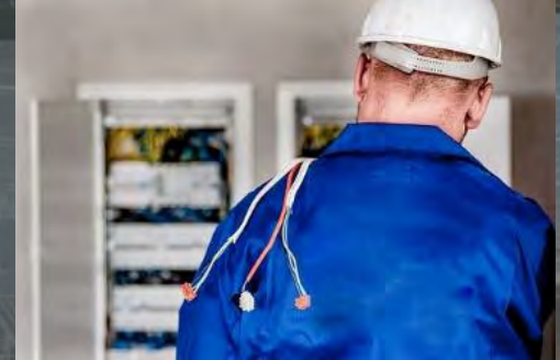
目視による監視
