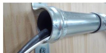
既設配管にて 追張り配線可能
