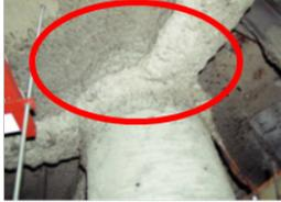
石綿含有断熱材、保温材、耐火被覆材(レベル2)
