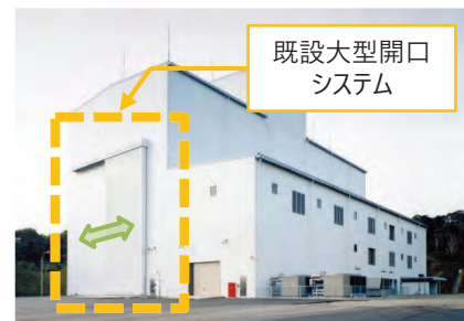
衛星フェアリング組立棟
