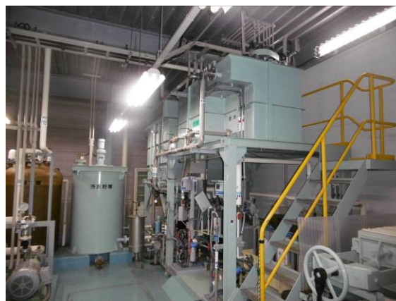
排水処理設備
