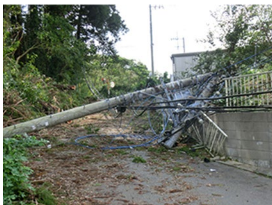
令和元年台風第 15 号による被害(千葉県山武市)
