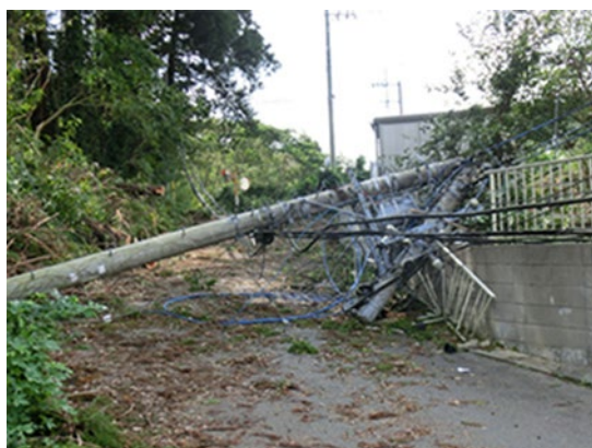
令和元年台風第 15 号による被害(千葉県山武市) 出典:国土交通省関東地方整備局ホームページ
