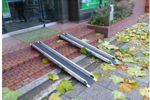
（階段に携帯用スロープを設置した状態）
