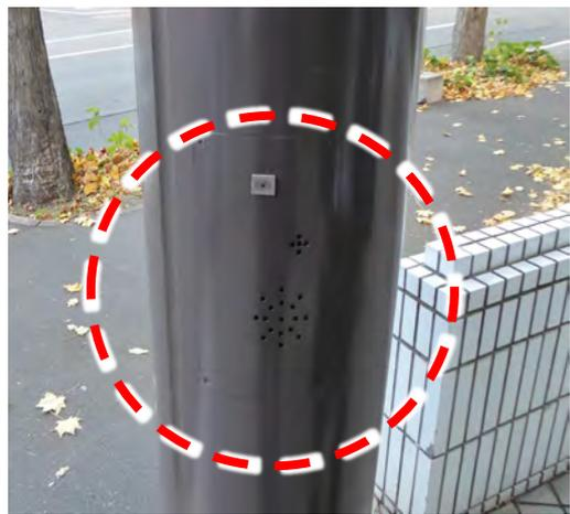
(玄関アプローチの柱に設置されている故障したままのインターホン設備)
