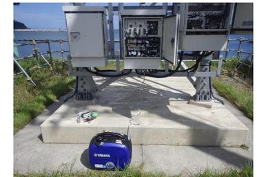
携帯発電機による電波確保
