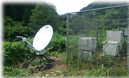
衛星基地局による エリア化
