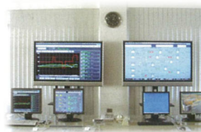
中央監視装置（市内全域の監視） ・各施設の運転状況や送水量を常時監視
