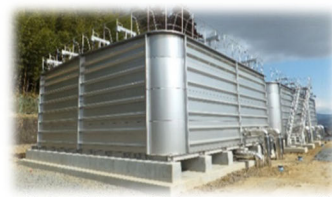
釣山配水池の更新（ダウンサイジング）
