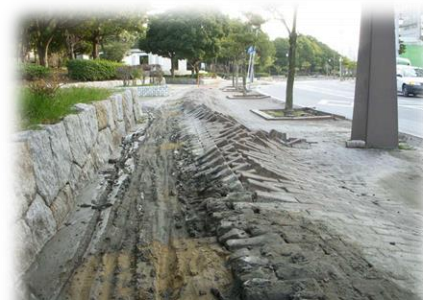
美浜区ひび野1丁目 (歩道の隆起・沈下)
