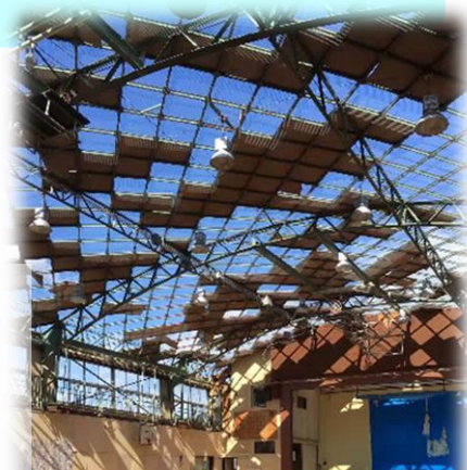
稲浜小学校の体育館
