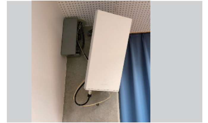
教室後方にローカル5Gアンテナが設置されている。
