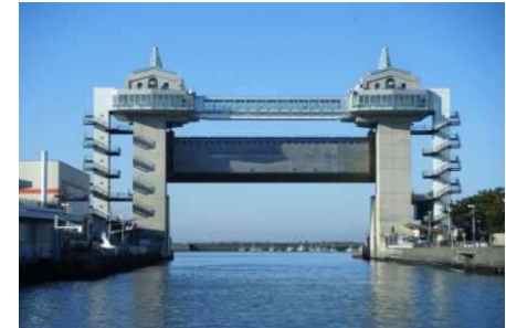
(水門の設置例)
