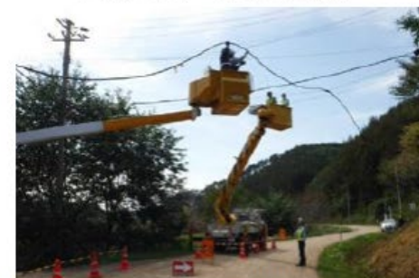
通信障害の応急復旧作業
