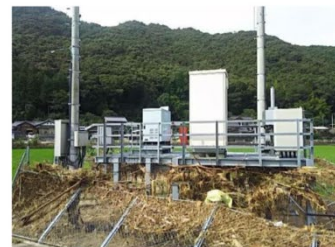
設備の高上げ (嵩上げ局は1.5倍程度のコストが必要)
