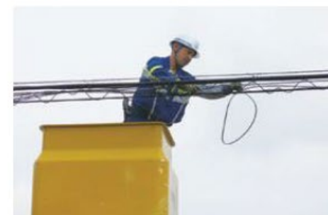
ケーブルなどの復旧活動
