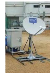
衛星回線設置
