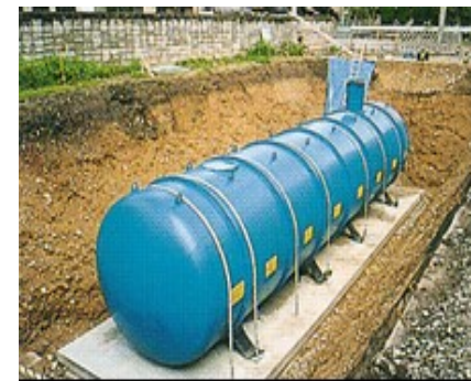
【耐震性貯水槽】
