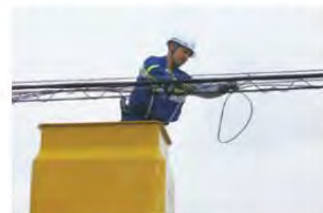
ケーブルなどの復旧活動
