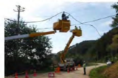
通信障害の応急復旧作業
