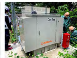
LPガス発電機
