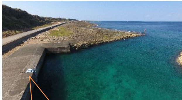
＜波力発電装置を設置した岸壁の様子＞
