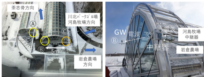
標津サーモン科学館屋上へのLoRa中継器設置
