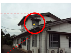
調査室 (親機設置場所)
