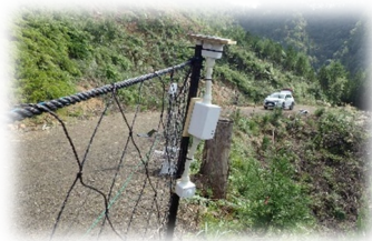
防護柵と設置したIoT
