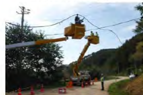
通信障害の応急復旧作業
