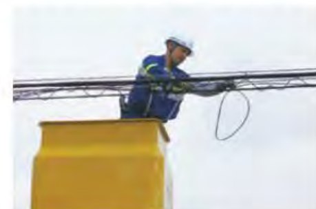
ケーブルなどの復旧活動
