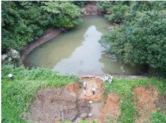
ため池堤体法面の崩落 (石川県志賀市)
