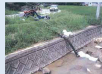
仮設ポンプを設置し、用水を確保
