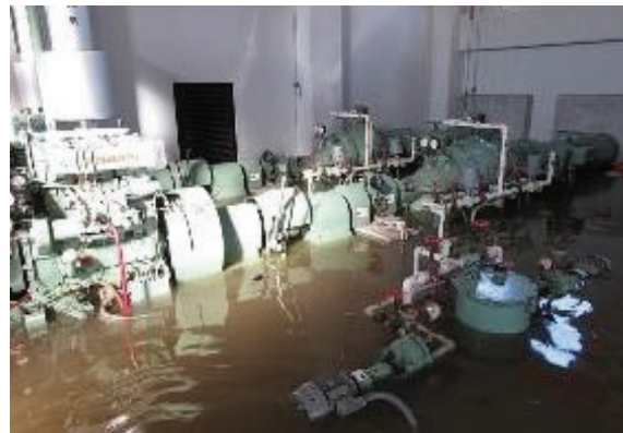
揚水機場の浸水被害 (宮城県角田市)
