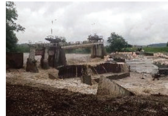
頭首工の損壊 (北海道北見市)
