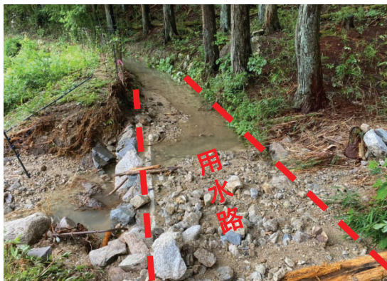
用水路の土砂埋塞 (岐阜県下呂市)
