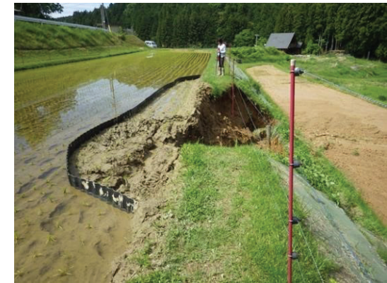
水田の法面崩落 (愛知県新城市)
