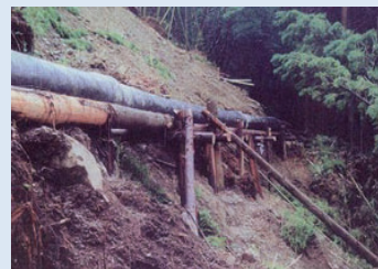
仮設水路を設置し、用水を確保
