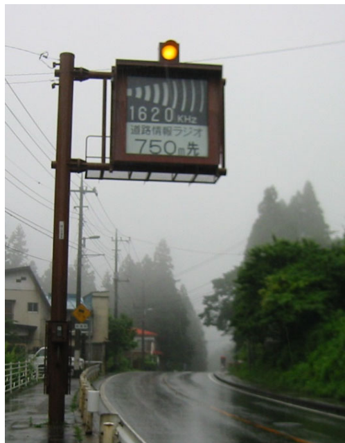
路側通信設備（標識）
