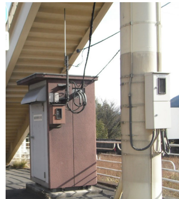
路側通信設備（局舎）
