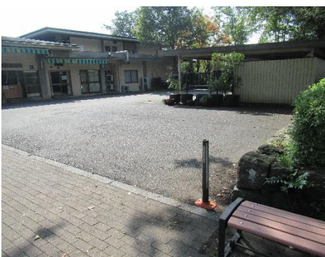
撤去した喫煙所
