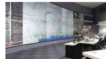
道路システム（交通管制）
