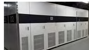
受変電システム（UPS）
