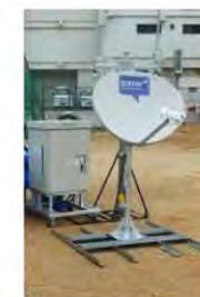
衛星回線設置
