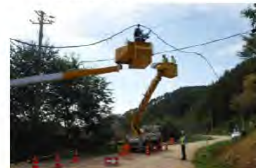
通信障害の応急復旧作業
