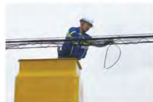
ケーブルなどの復旧活動
