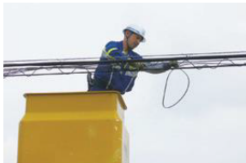
ケーブルなどの復旧活動
