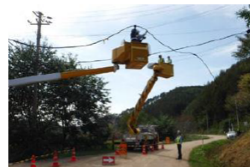
通信障害の応急復旧作業
