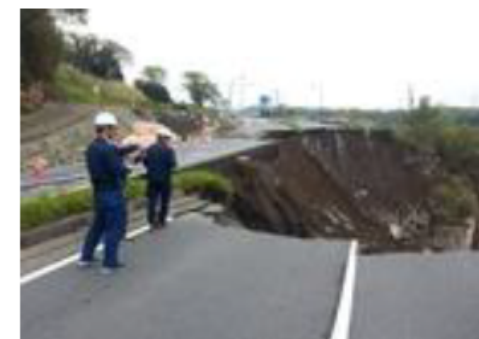
道路崩落により切断された中継光ケーブル
