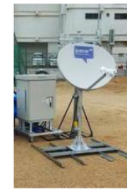
衛星回線設置
