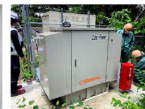
LPガス発電機
