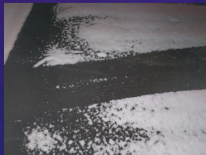
路面画像を撮影
