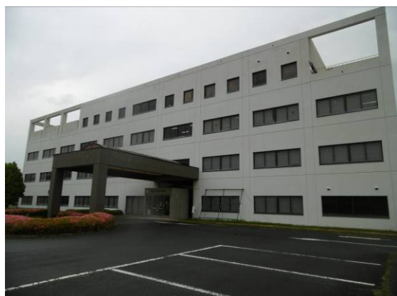
エントリー外観
